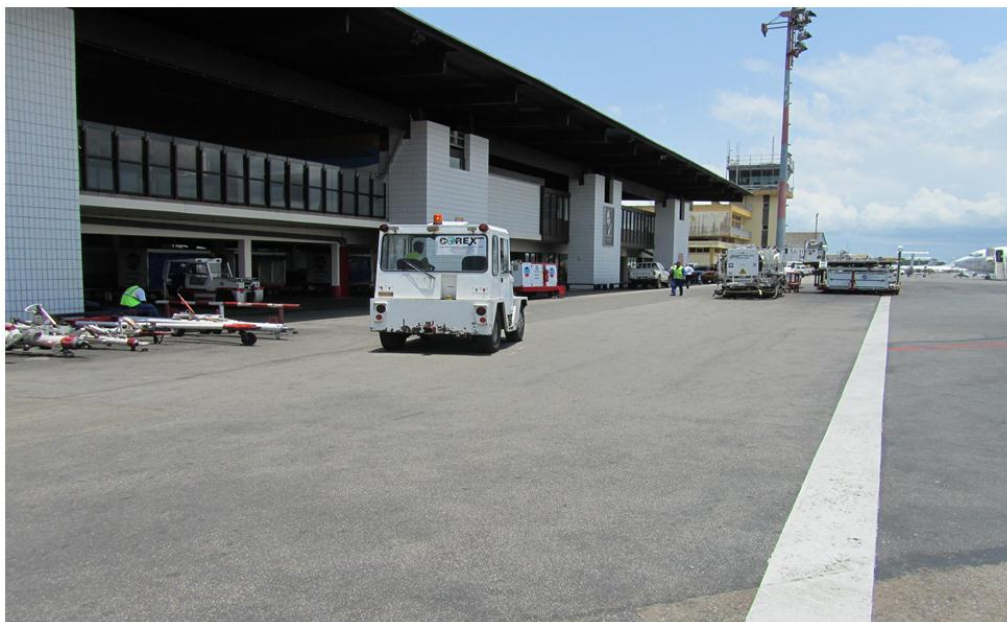
Illustration 1 : Une ligne blanche délimite la frontière entre la route de service au contact de l'aérogare et l'aire de trafic
